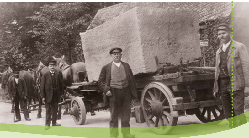
Abtransport der Porphyrböcke mit dem Pferdewagen 1931
