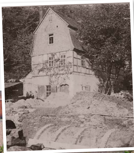
Alte Lohmühle beim Abriss um 1899
